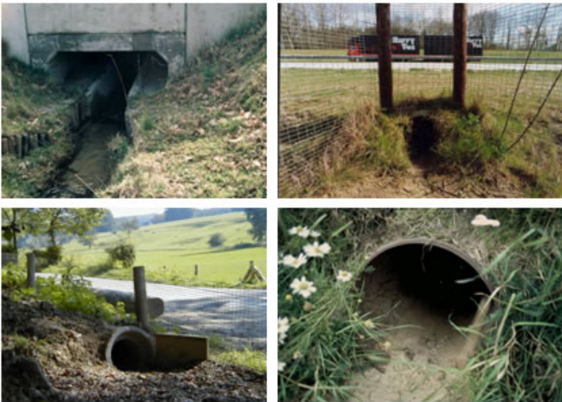
供小型動物使用之穿越式廊道 (luell, etc. Eds., 2003)
